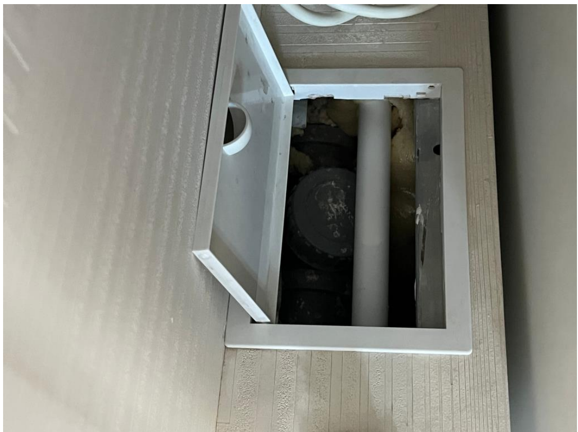
Фото 2. Ревизионный люк для подключения перенесенной кухонной раковины
