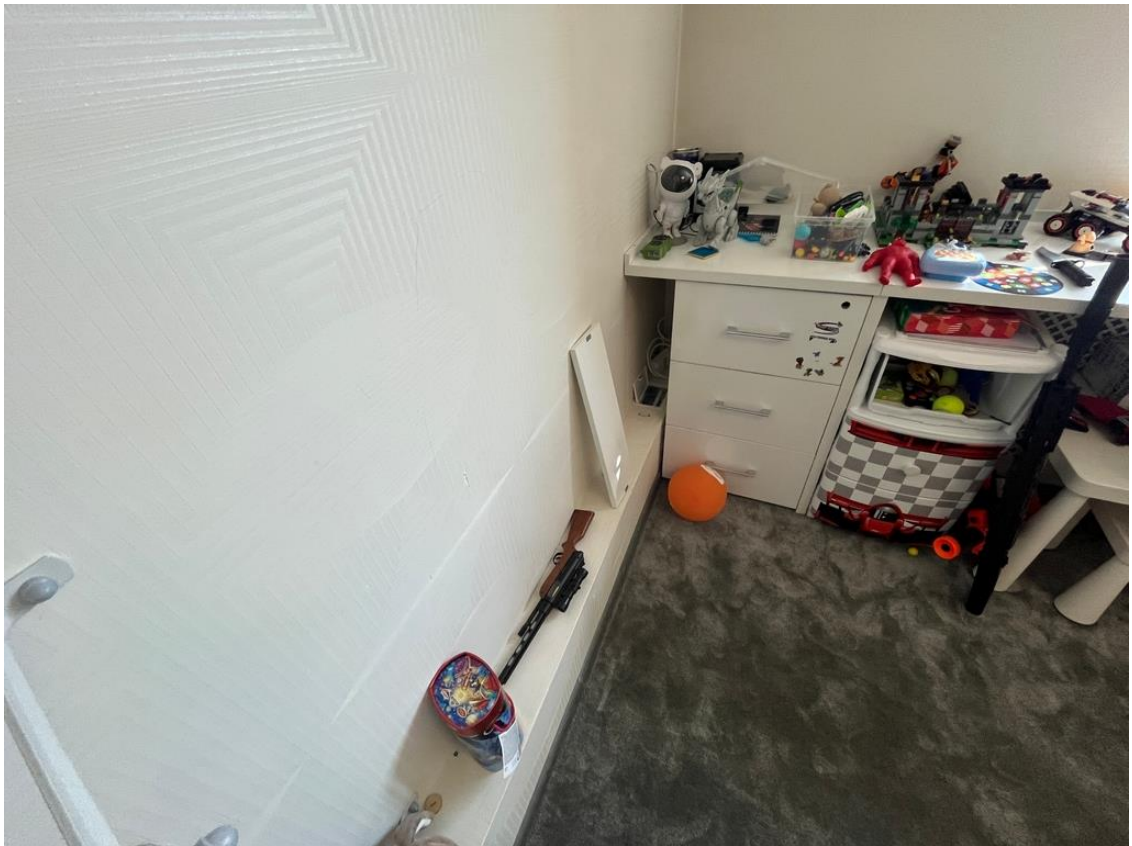
Фото 1. Общий вид короба с коммуникациями для подключения перенесенной кухонной раковины
